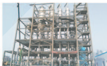
化工行业高盐废水—多效蒸发
