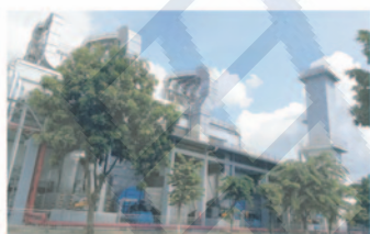
涂装线有机废气处理工程
